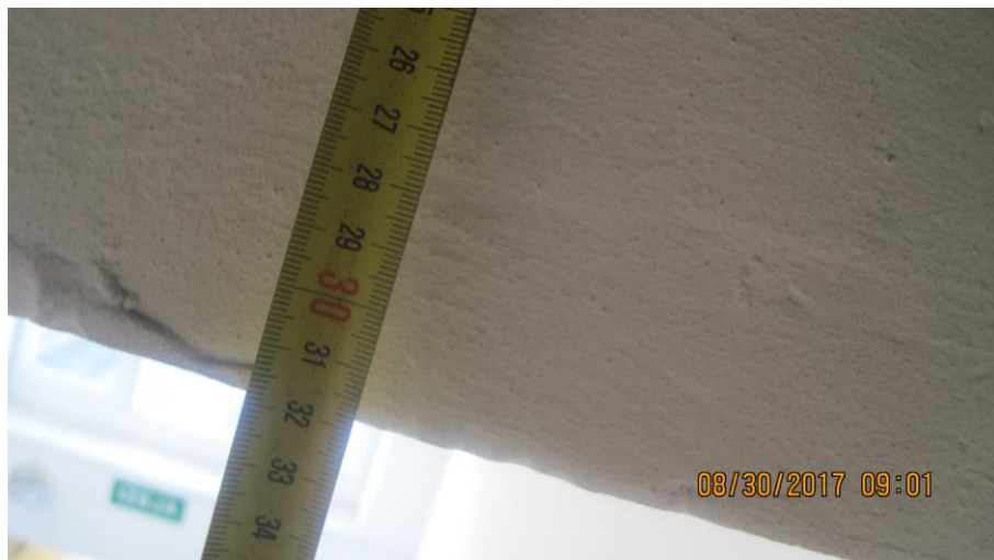
Jumta un bēniņu pārsegums, papildus jāsiltina
